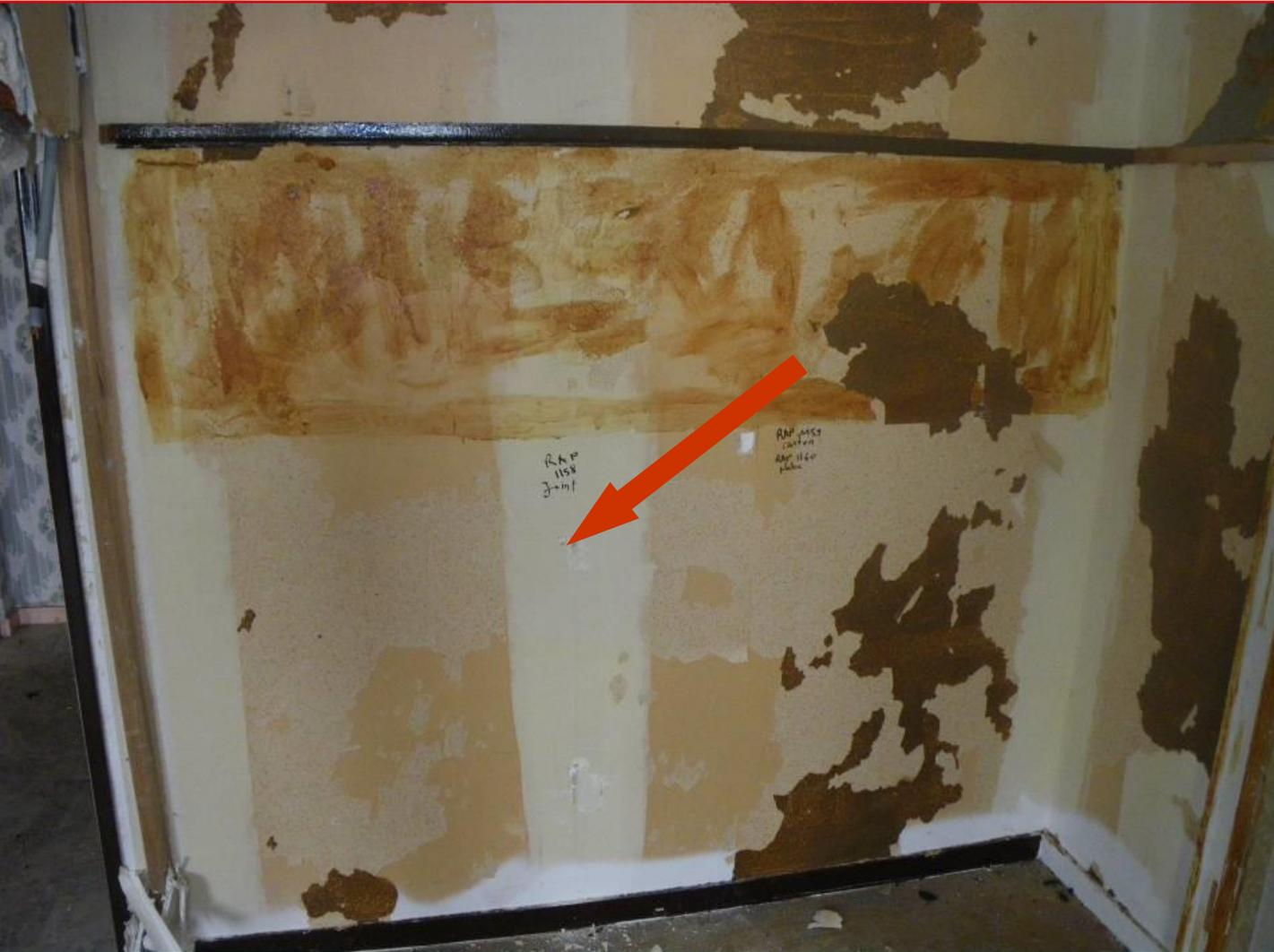
Joint de Placoplâtre BA 13 amianté
