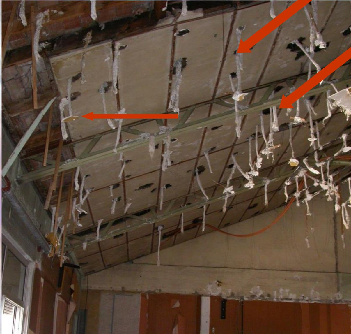
Suspentes de faux plafond recouvertes de plâtre amianté
