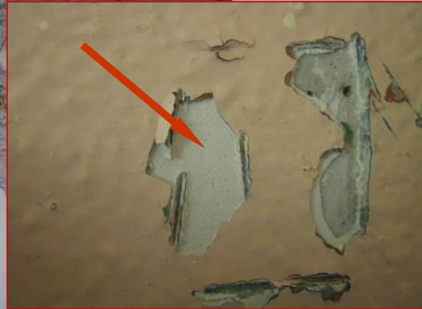
Enduit plâtre anti-bullage amianté (ou enduit ciment)
