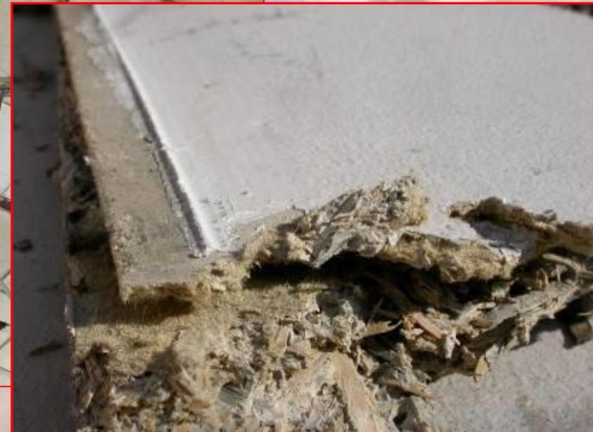
Faux plafond composé de fibre de cellulose et de fibres d'amiante (menuisierite).
