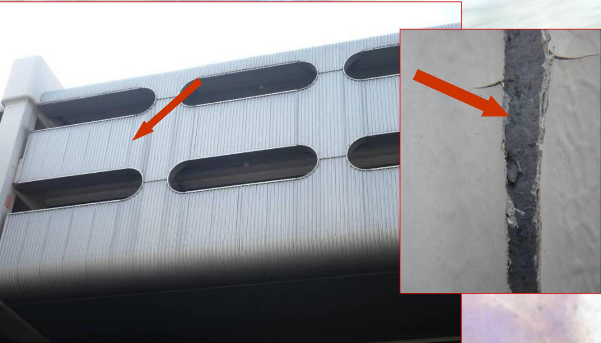
Galbestos : bardage métallique amiante sur sa face extérieure
