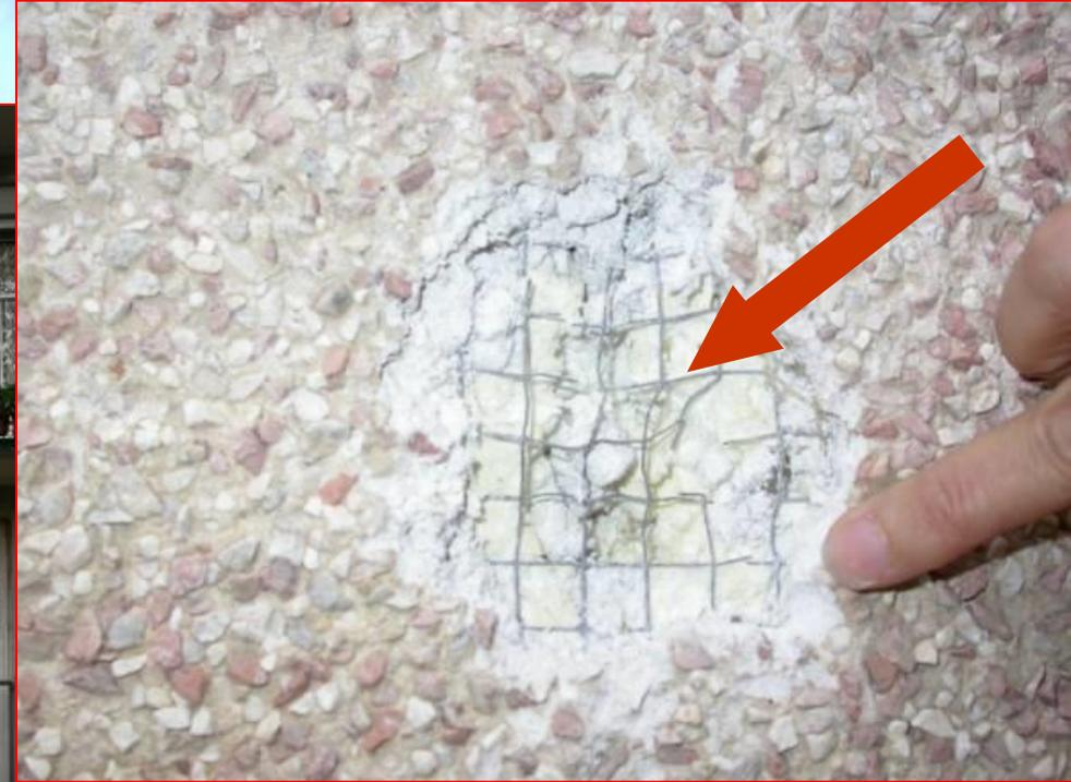
Bourre d'amiante entre un revêtement d'aspect béton lavé et plaque de polystyrène expansé (isolation année 1970)
