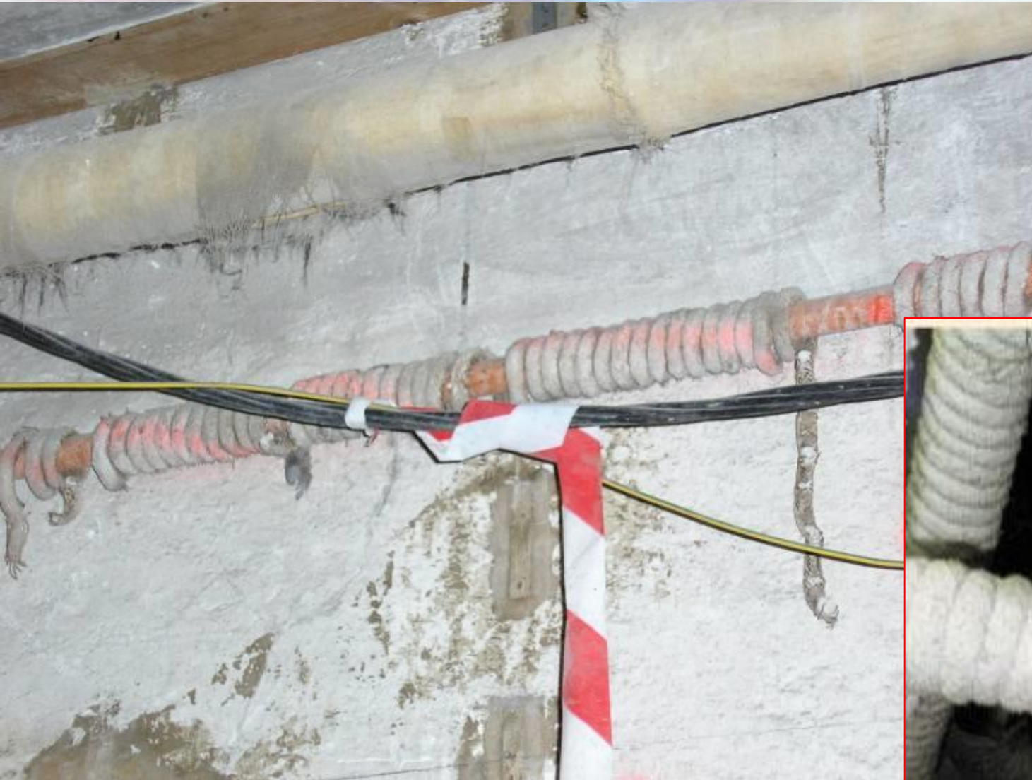
Calorifuge à base de tresses amiantées
