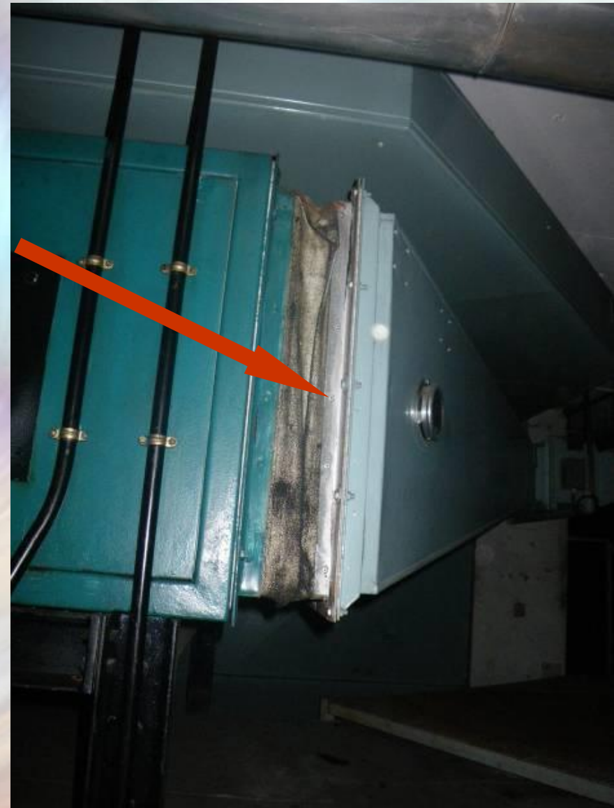
Manchon amianté (tresse ou autre) entre éléments métalliques
