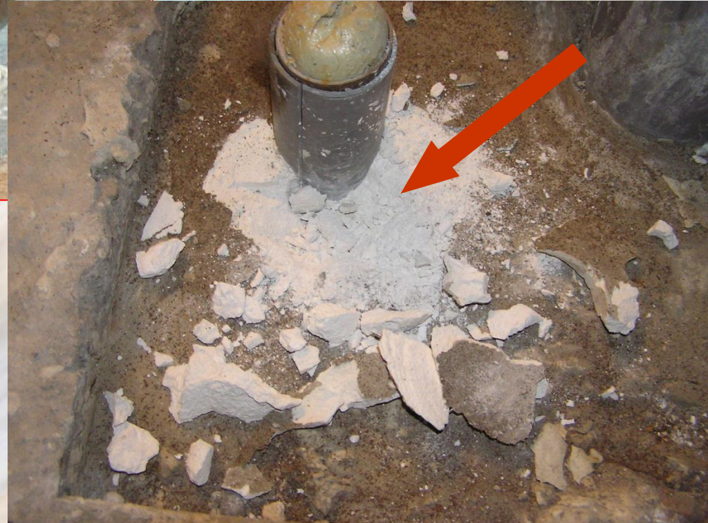
Plâtre amianté pour rebouchage
