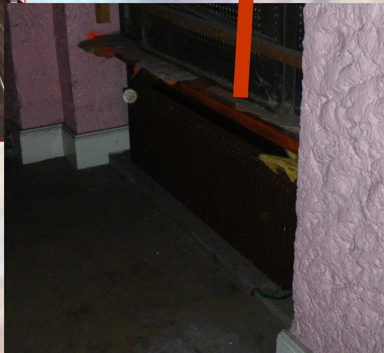
Plaque carton ou fibro au dessus de radiateur
