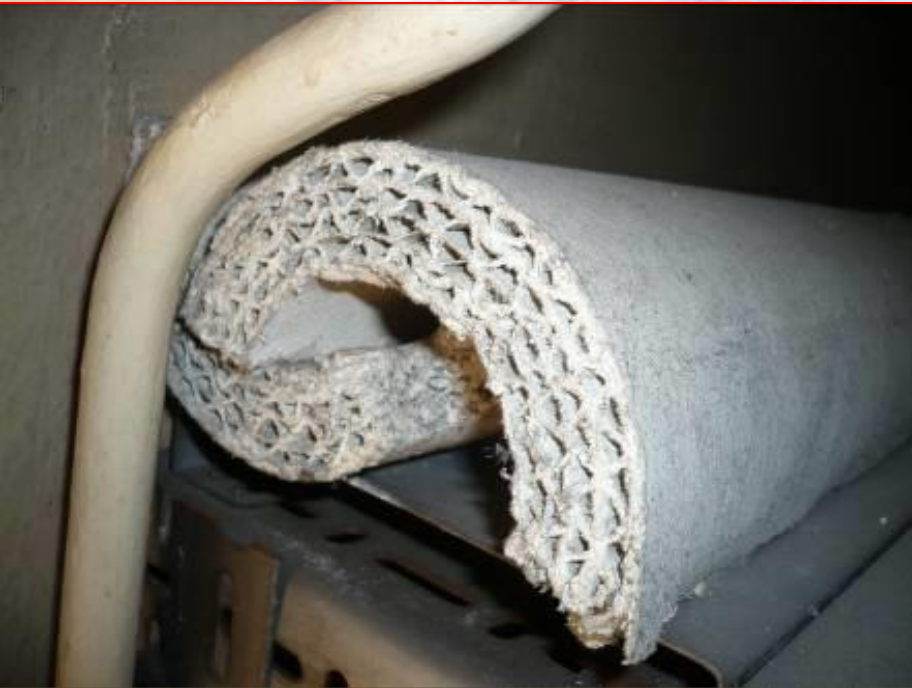
Calorifuge en carton amiante
