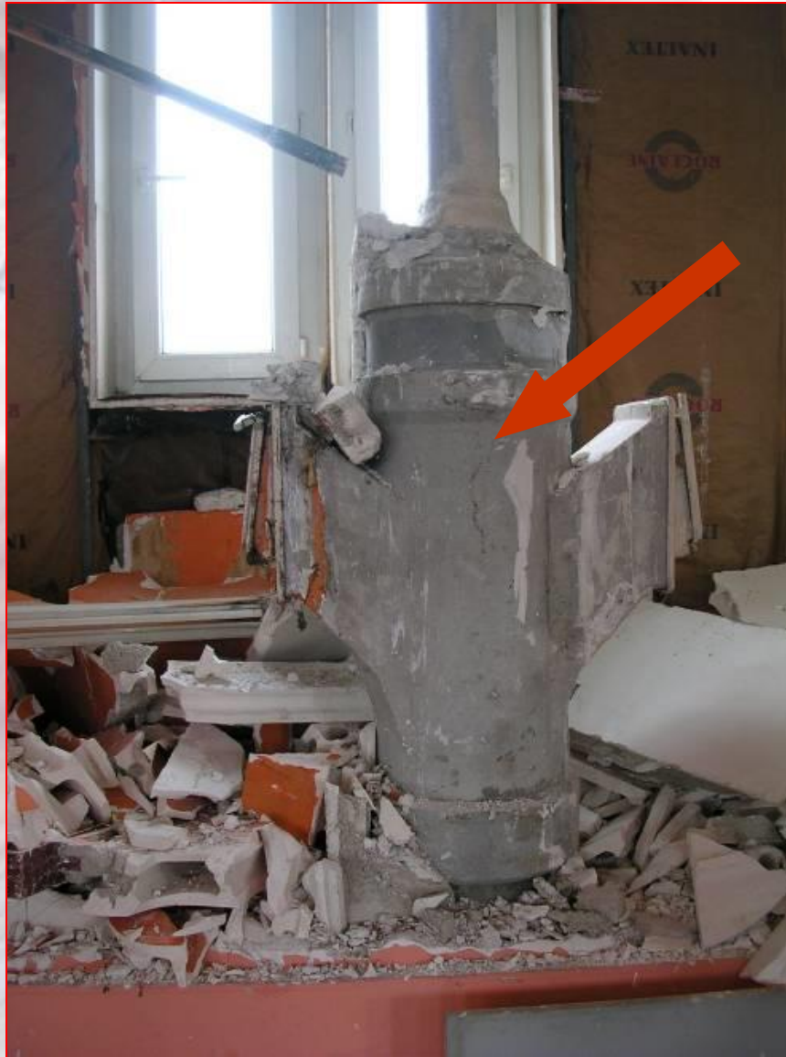
Conduit de vide ordure en fibrociment
