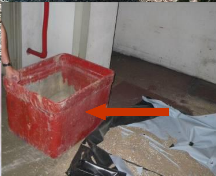
Jardinières et bac de sable en fibrociment
