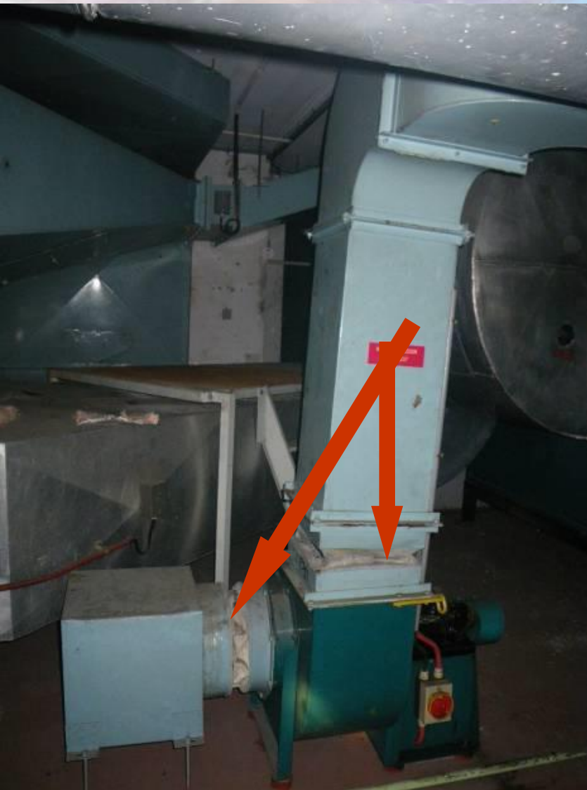
Manchon amianté (tresse ou autre) entre éléments métalliques
